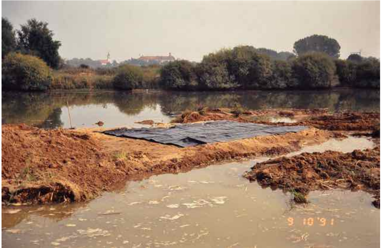
Abb. 2: Die Folie muss unbedingt weit ins Wasser reichen, damit die Insel keine umlaufende Gehölzbarriere bekommt und damit für die meisten Limicolen unattraktiv wird. Bau: 1991.
