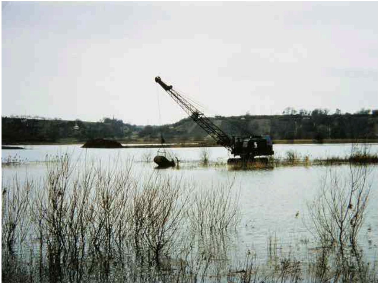
Abb. 5: Der Bagger auf der überfluteten Insel. Die Ölfässer wären abgetrieben. © H. Schödel.
