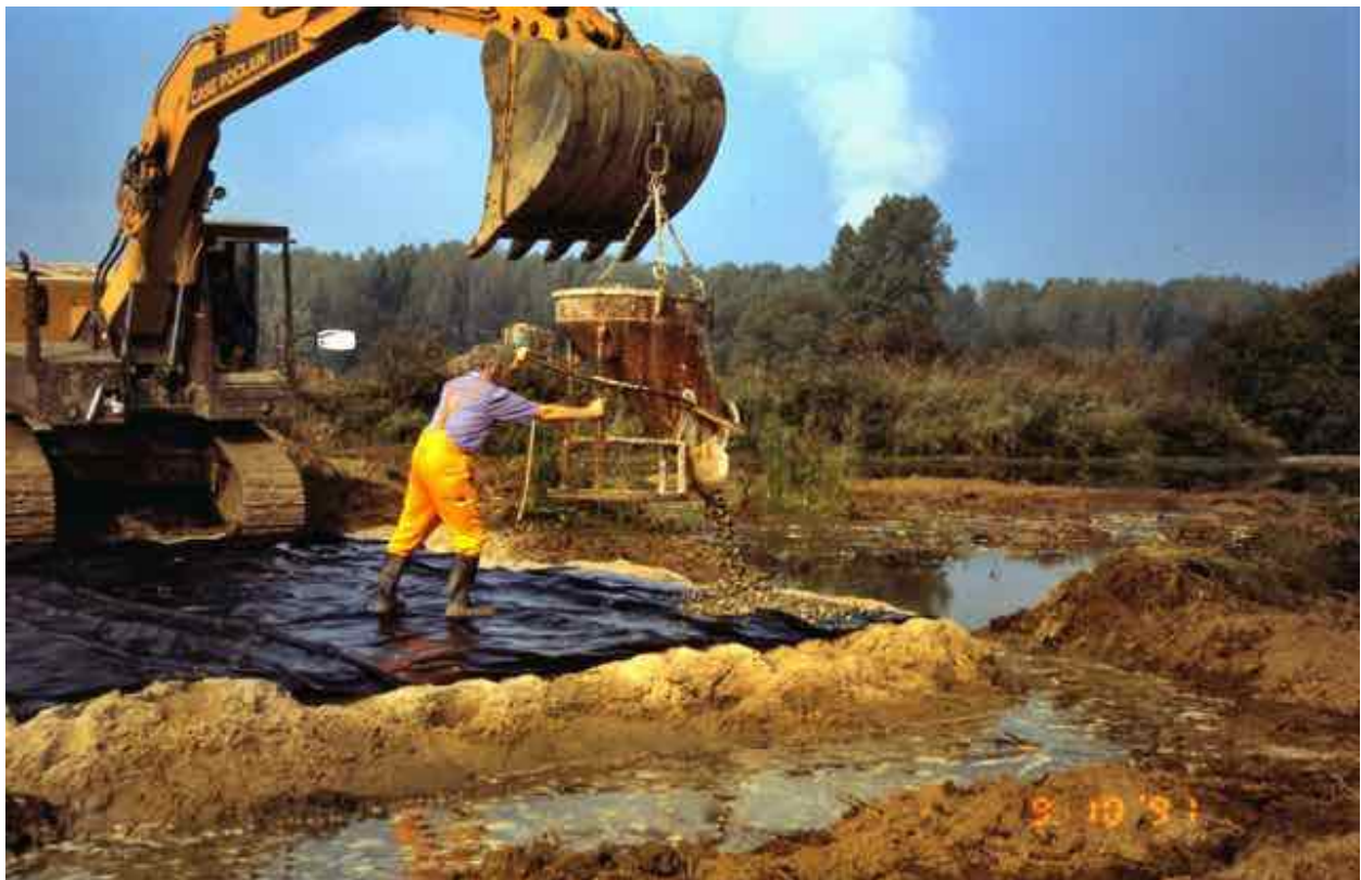
Abb. 1: Die Folie wird auf ein Sandbett gelegt und mit grobem, gewaschenen Kies bedeckt.
