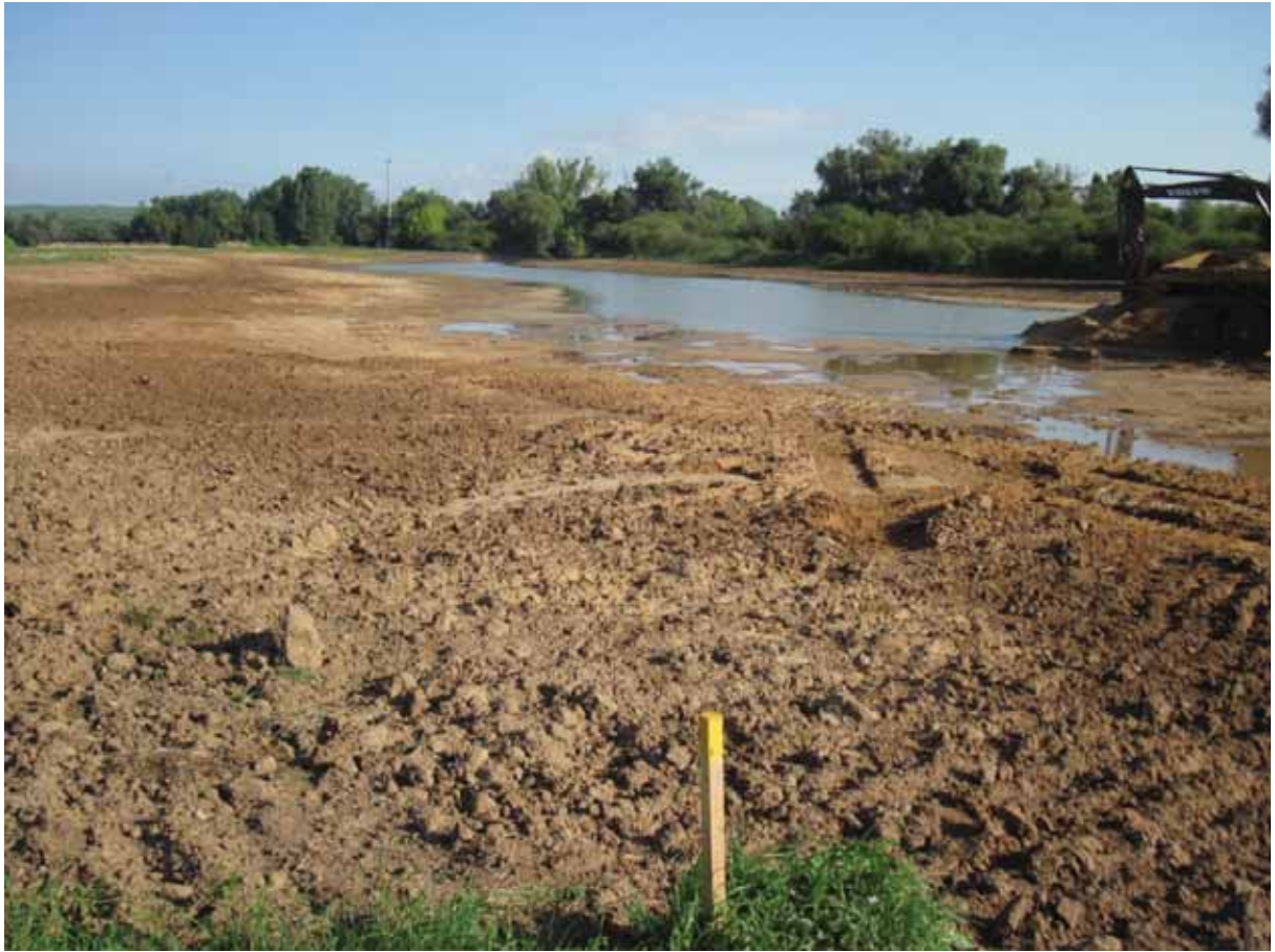
Bauphase im September 2013
