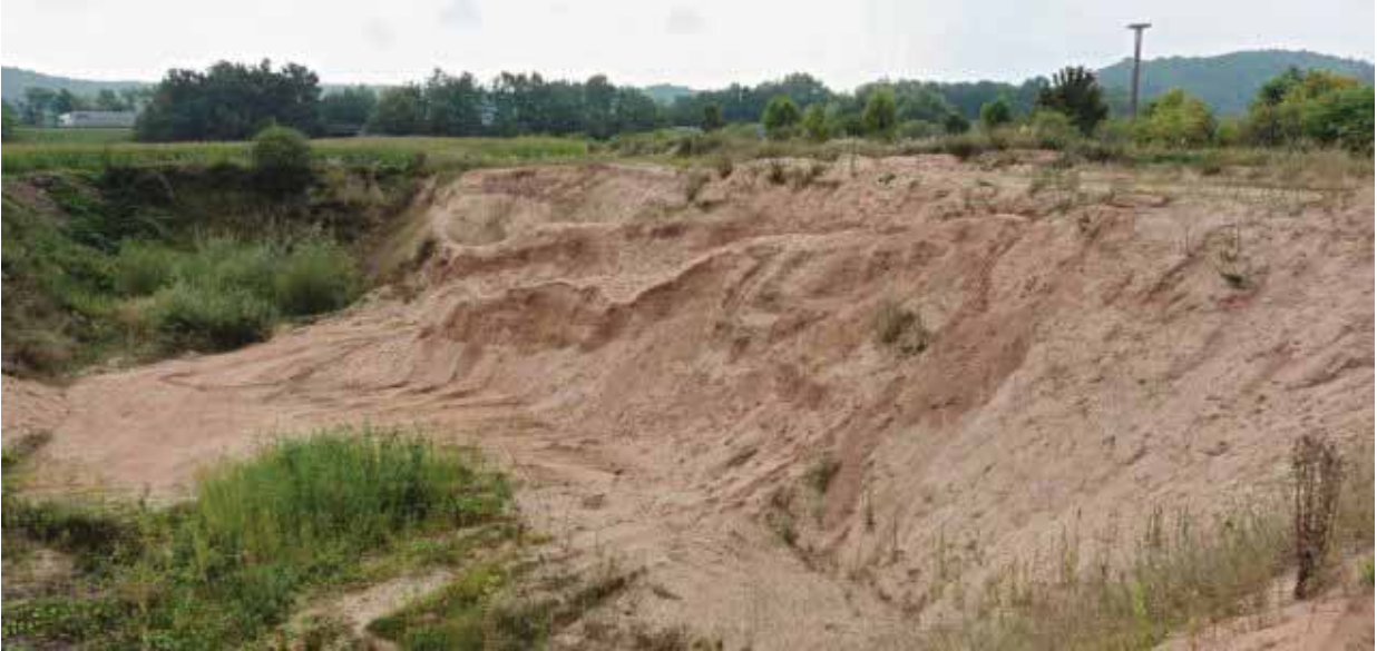
Zusammengebrochene Sandgrube Hutzelmühle bei Geiselwind.
